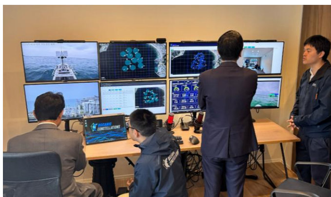
管制室モニタパネル表示情報の説明風景
